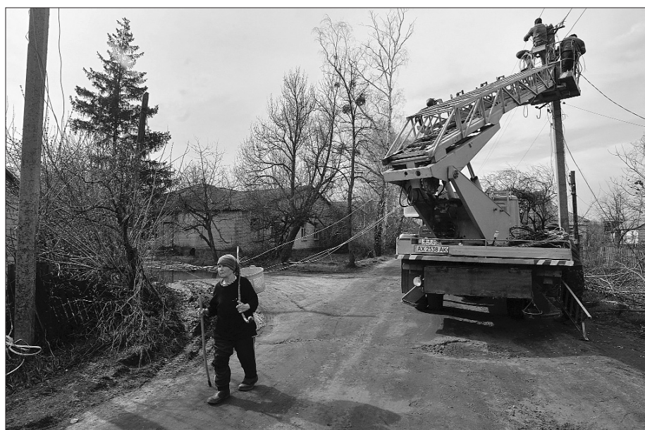
У селі Студенок Ізюмського району Харківської області електротехніки «Харківобленерго» ремонтують лінію електропередач.
